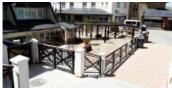
VISTA DE TERRAZA A IMPERMEABILIZAR
