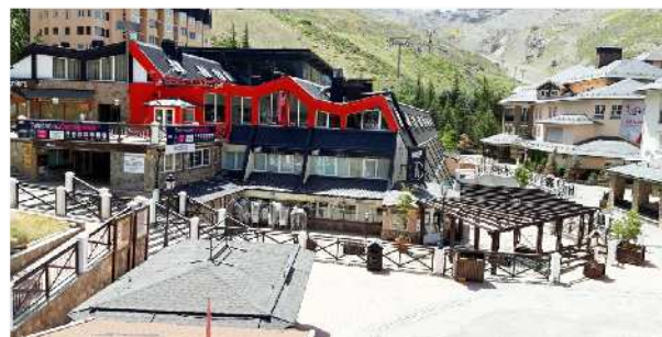
VISTA DE TERRAZA A IMPERMEABILIZAR
