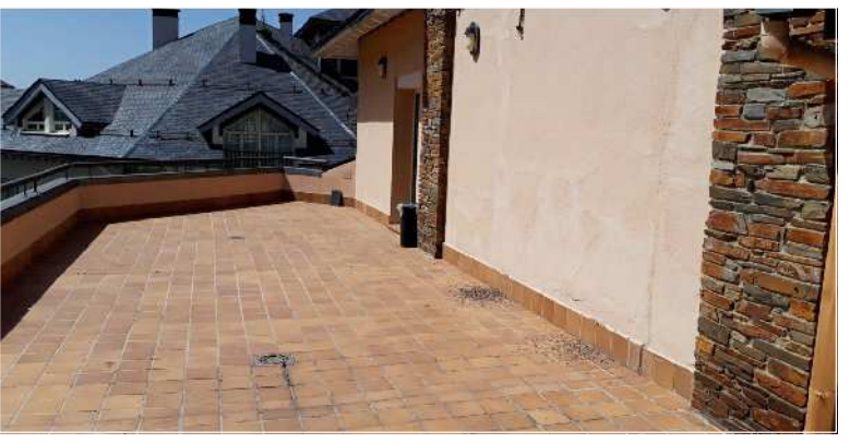
Terraza a Valle, zona Sur
