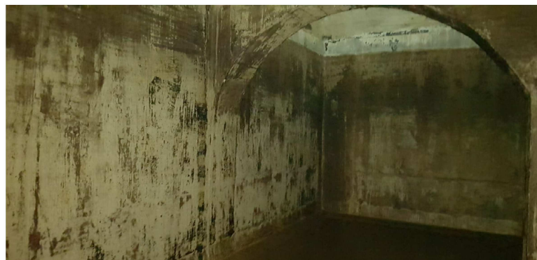
Vista interior de vaso, estado de impermeabilización
