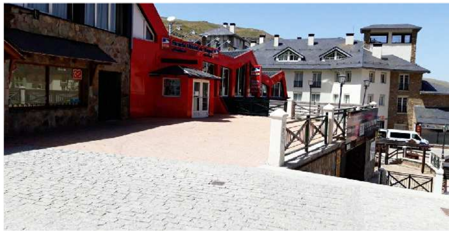
VISTA DE TERRAZA A IMPERMEABILIZAR
